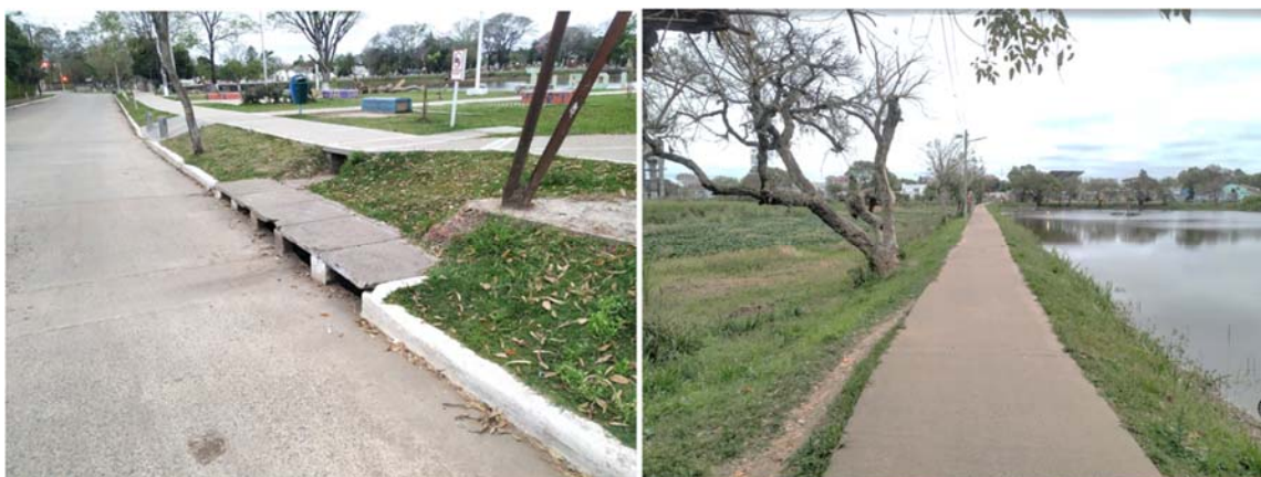
Figura 2: Boca de tromenta y alcantarillado. Terraplen que atraviesa la laguna a la mitad.
