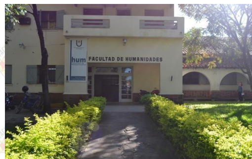
Ingreso por Avenida Castelli
